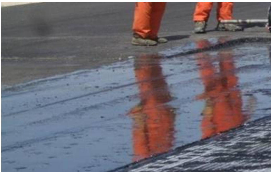
6.1-4 attēls. Spoguļa efekts svaigi izsmidzinātā saistes slānī un melni nospiedumi uz ģeokompozīta pēc pareizas ieklāšanas uz pareizi izsmidzinātas saistvielas
