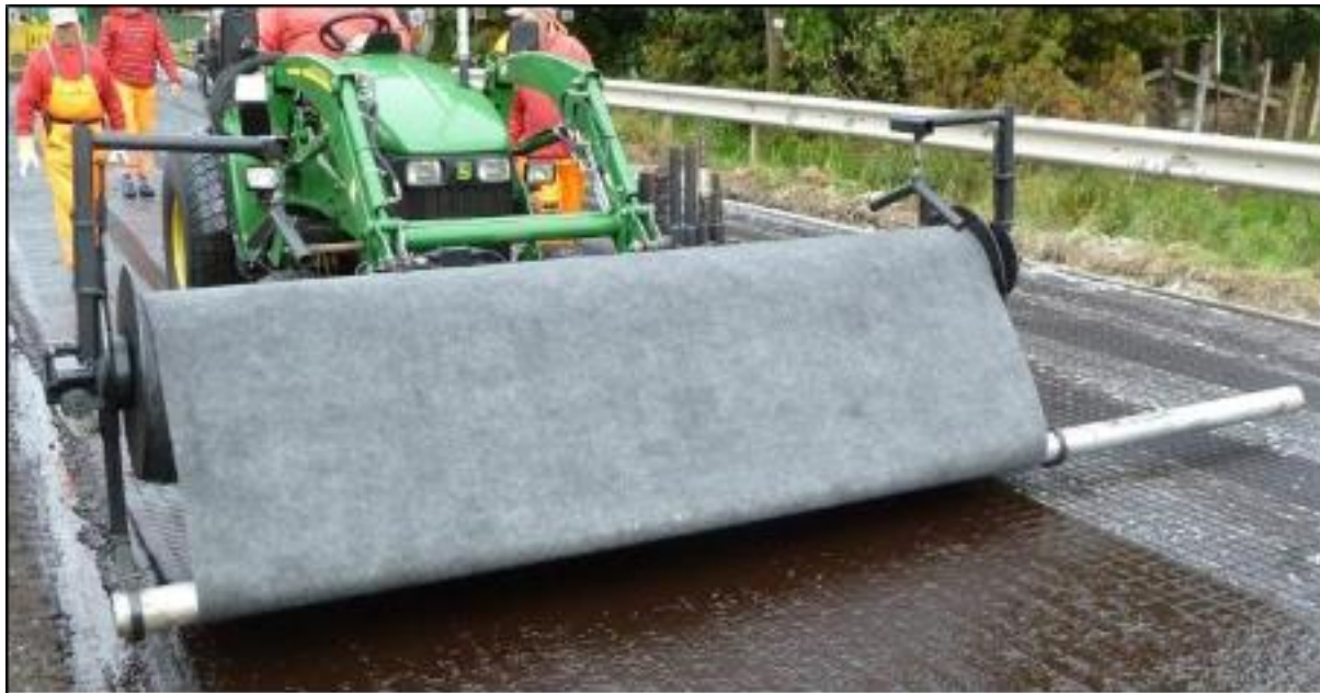
6.1-1 attēls. Ģeokompozīta mehāniska ieklāšana
