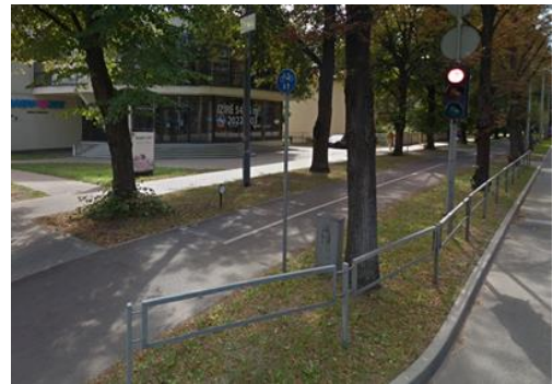
4.5.attēls. Velosipēdu ceļš Brīvības ielā, Rīgā (Google Street View)
