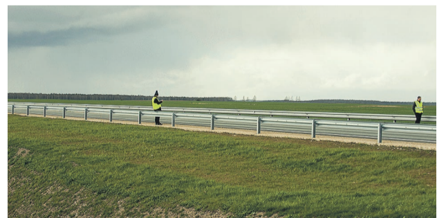
Ceļš nav tikai segums, pa kuru brauc automašīnas. Ceļmalu barjeras atsevišķos posmos pilda drošības funkcijas.
