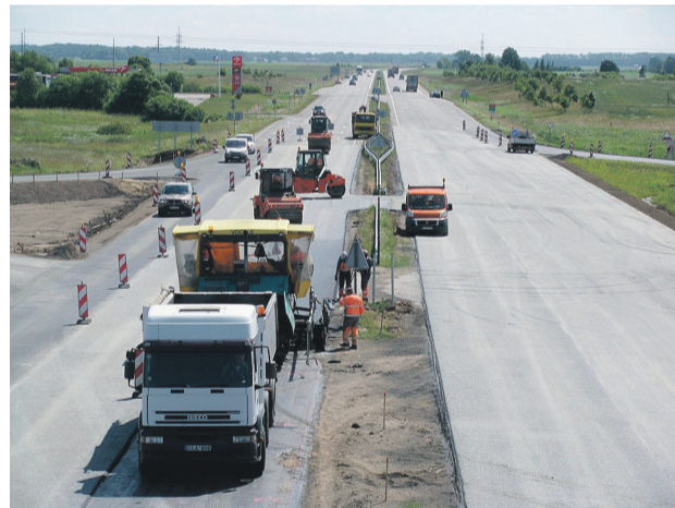
Palangas apvedceļa būvniecība.
