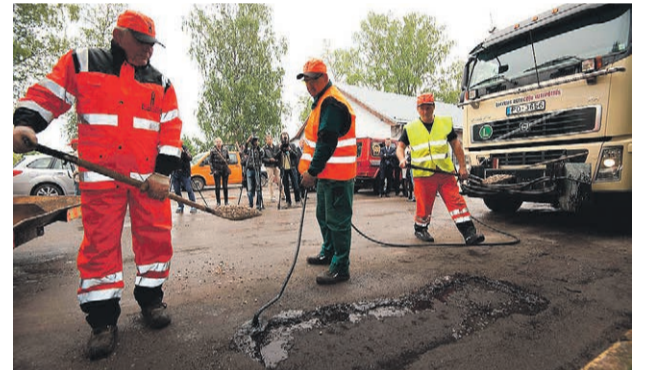
Pēc tam, lai nodrošinātu nepieciešamo sasaisti ar šķembām, tiek veikta bedres gruntēšana ar bitumena emulsiju.
