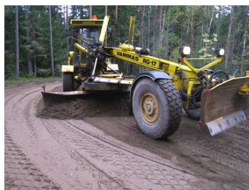
7-17 attēls. Stabilizētās kārtas profilēšana
