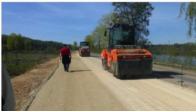
7-18 attēls. Stabilizētās kārtas sablīvēšana
