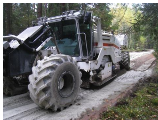
7-16 attēls. Saistvielas iemaisīšana ar recikleru, vienlaicīgi pievienojot ūdeni
