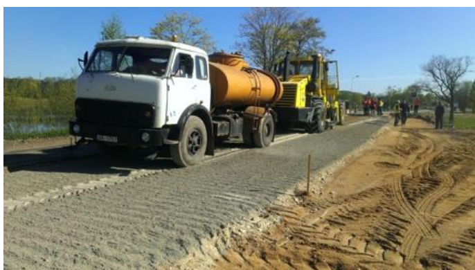
7-16 attēls. Saistvielas iemaisīšana ar recikleru, vienlaicīgi pievienojot ūdeni
