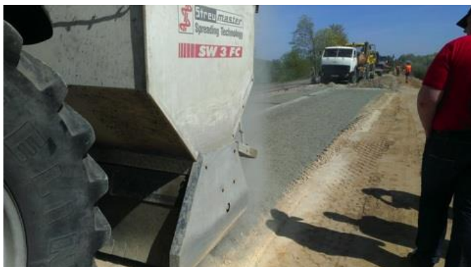
7-15 attēls. Saistvielas izbēršana uz stabilizējamās grunts
