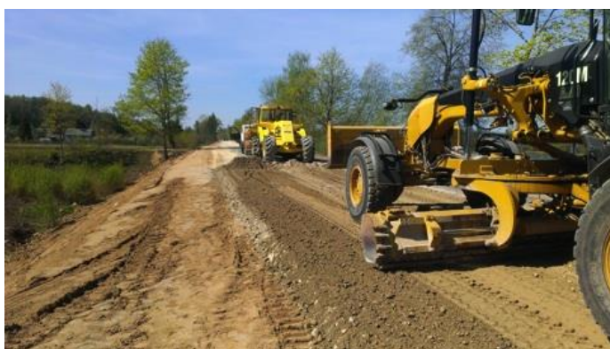
7-17 attēls. Stabilizētās kārtas profilēšana
