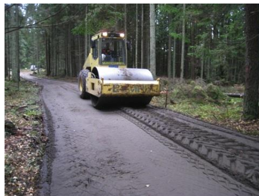
7-18 attēls. Stabilizētās kārtas sablīvēšana
