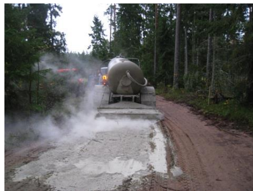
7-15 attēls. Saistvielas izbēršana uz stabilizējamās grunts
