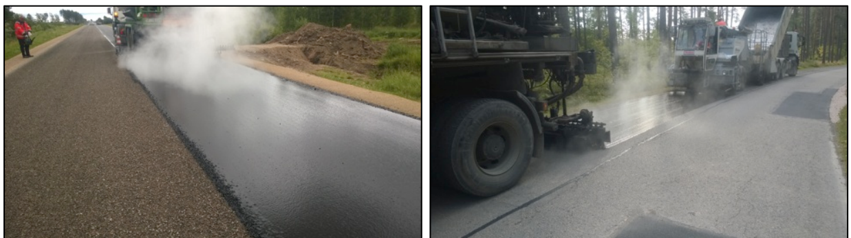
7-5. attēls. Virsmas apstrāde uz asfalta seguma
