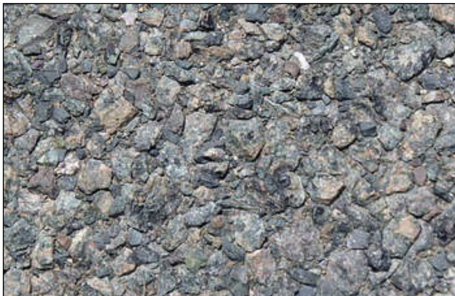
7-9. attēls. Virsmas apstrādes tekstūra pēc noformēšanās
