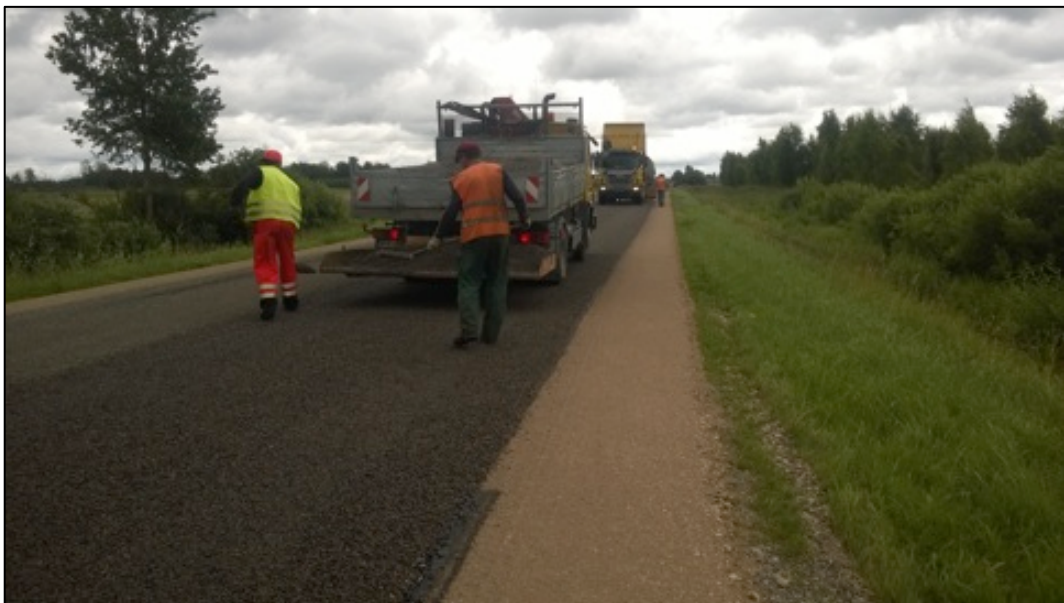
7-7. attēls. Uzbērtās virsmas apstrādes kārtas tūlītēja pielabošana
