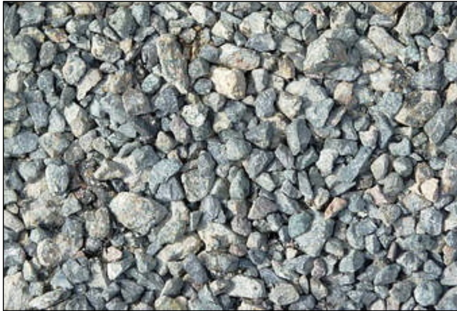
7-8. attēls. Virsmas apstrādes tekstūra tūlīt pēc uzbūvēšanas
