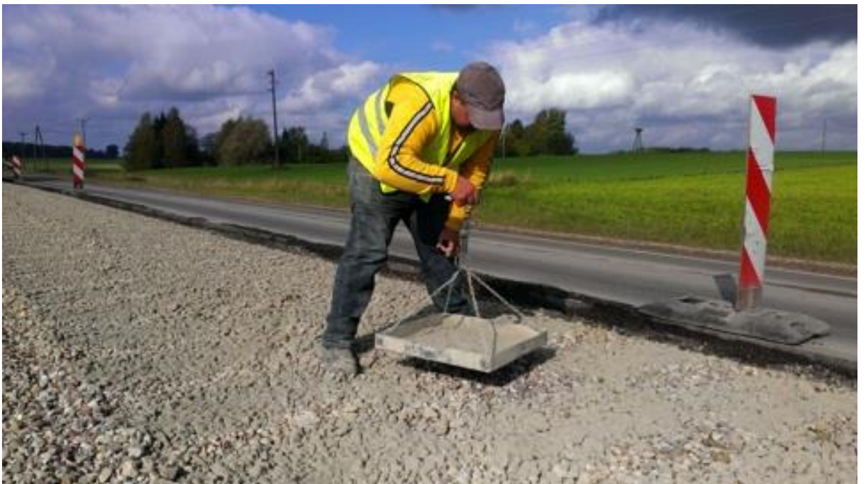
7-4. attēls. Izbērtā cementa daudzuma kontrole
