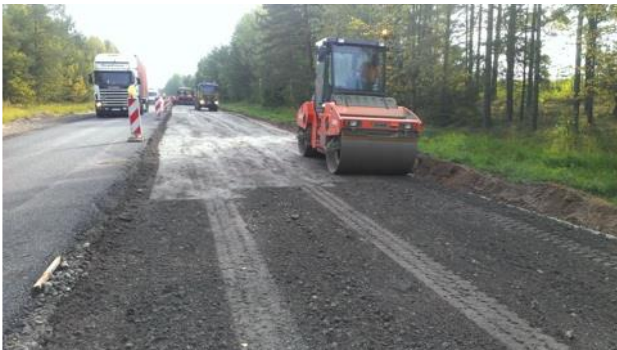
7-10. attēls. Ieklātās apakšējās kārtas sablīvēšana
