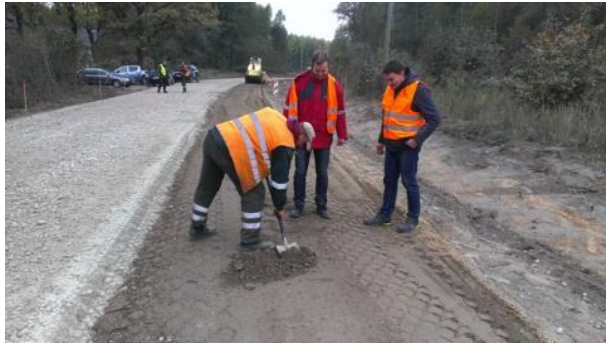
7-7. attēls. Sablīvētās kārtas biezuma uzmērīšana
