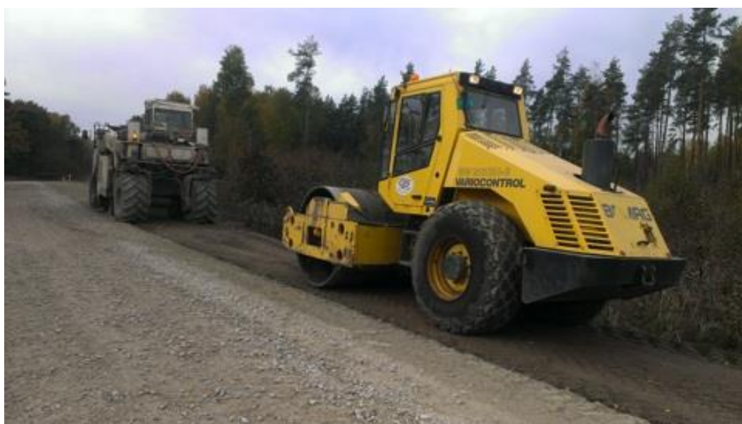
7-6. attēls. Ar recikleru samaisītās kārtas pieblīvēšana
