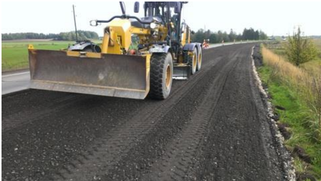
7-8. attēls. Ar recikleru samaisītās joslas profilēšana ar autogreideru
