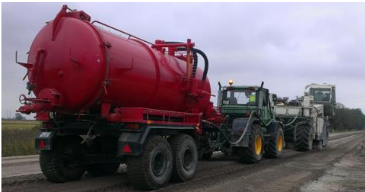
7-5. attēls. Maisījuma samaisīšana ar recikleru, vienlaikus pievienojot arī ūdeni
