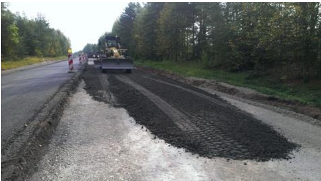
7-9. attēls. Ar cementu saistītās apakšējās kārtas ieklāšana ar autogreideru
