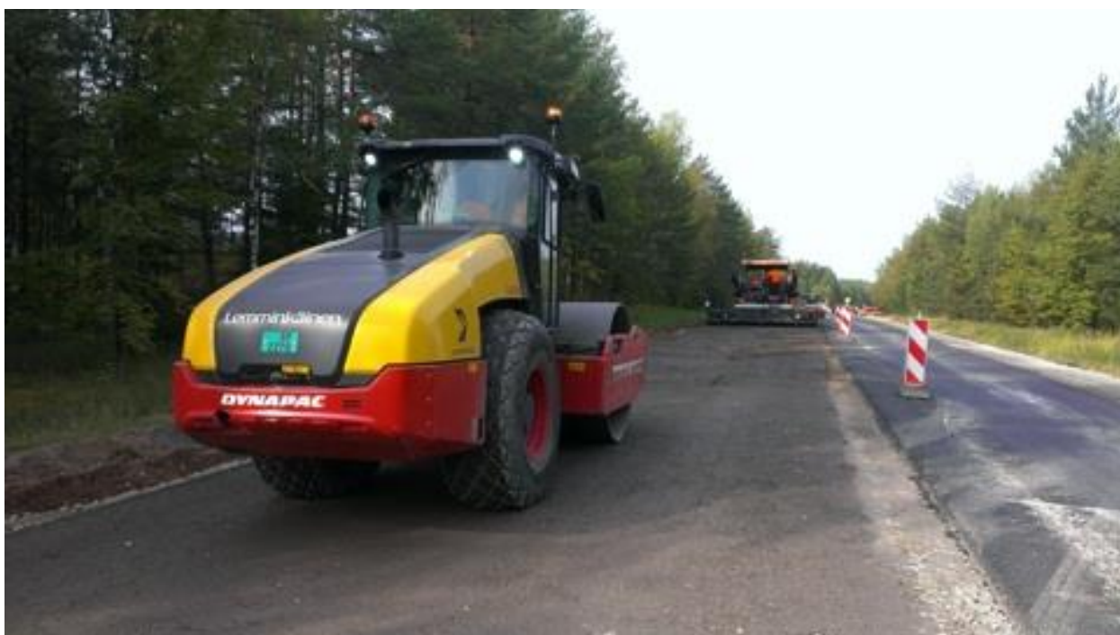
7-12. attēls. Ieklātās augšējās kārtas sablīvēšana
