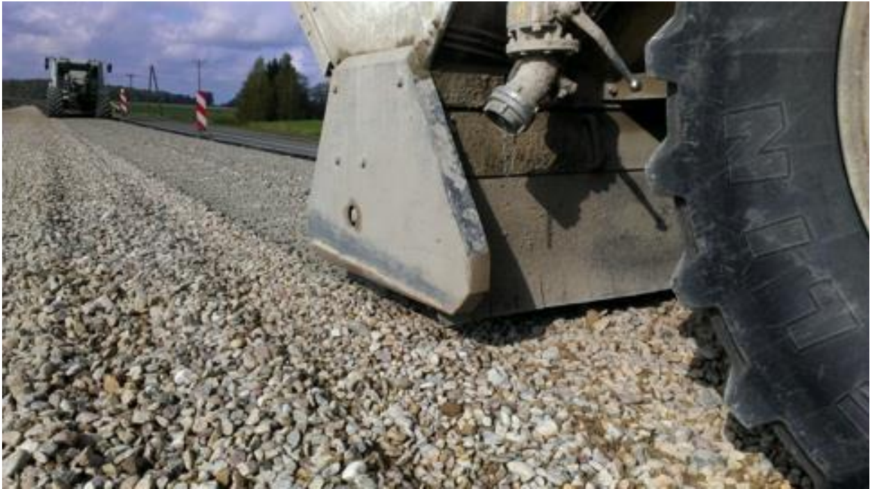
7-3. attēls. Cementa izbēršana
