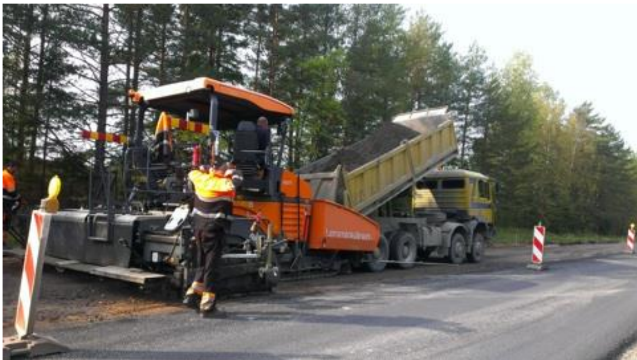
7-11. attēls. Rūpnīcā sagatavota ar cementu saistīta maisījuma augšējās kārtas ieklāšana ar ieklājēju
