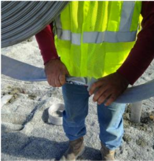
7.14. attēls. VD pārlaiduma izveide [25]
