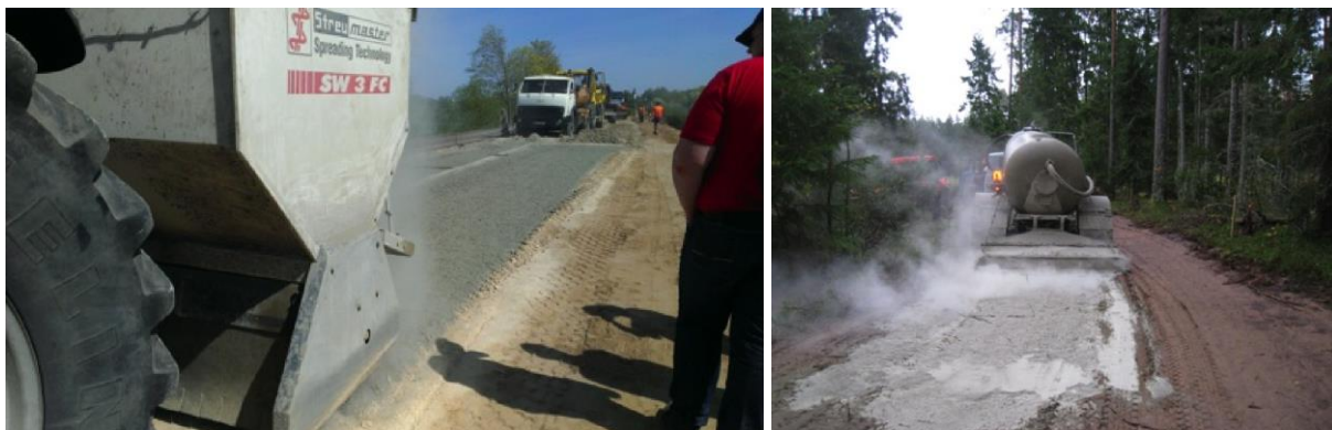
12.10. attēls. Saistvielas izbēršana uz stabilizējamās grunts
