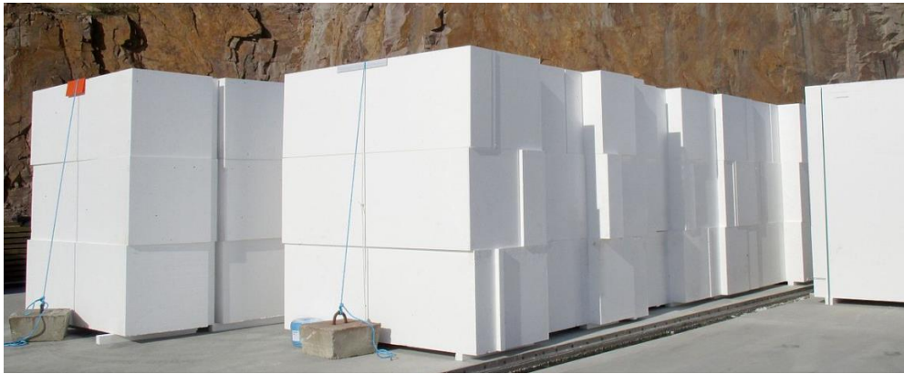
6.24. attēls. Bloku pagaidu nostiprināšana objektā [58]
