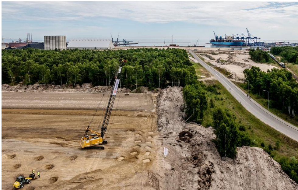
5.6. attēls. Grunšu dinamiskā blīvēšanas uz lauka [36]
