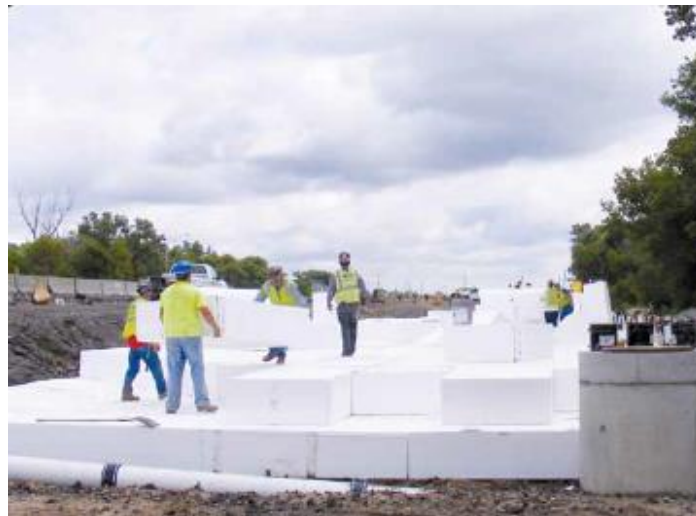
6.22. attēls. EPS bloku izbūves process [53]
