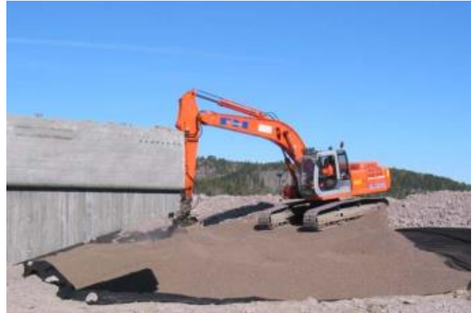
6.20. attēls. Keramzītoļu izklāšana ar kāpurķēžu ekskavatoru [48]
