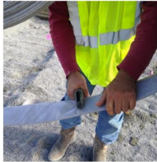
7.15. attēls. VD savienojuma nostiprināšana [25]
