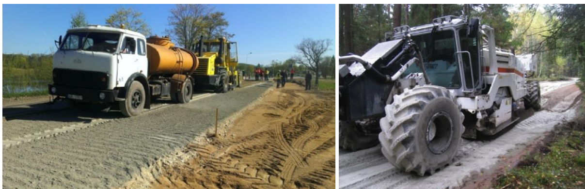
12.11. attēls. Saistvielas iemaisīšana ar recikleru, vienlaikus pievienojot ūdeni
