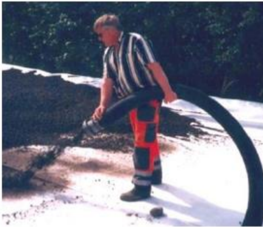
6.19. attēls. Keramzītoļu izklāšana ar pūšanas paņēmienu [48]
