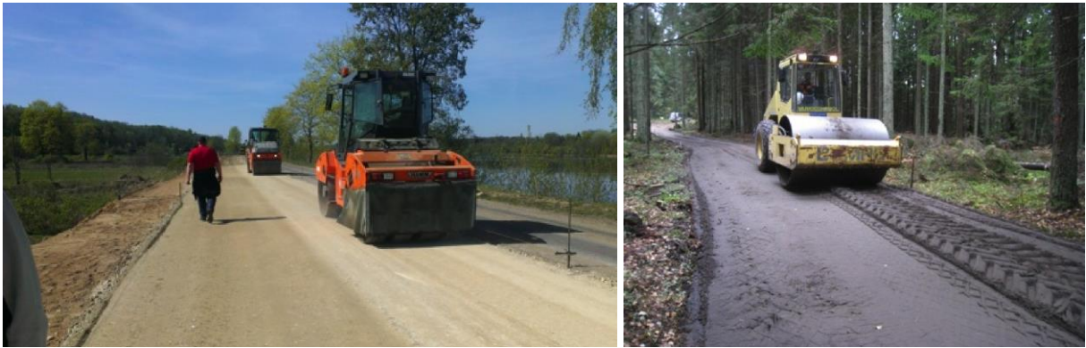
12.13. attēls. Stabilizētās kārtas sablīvēšana
