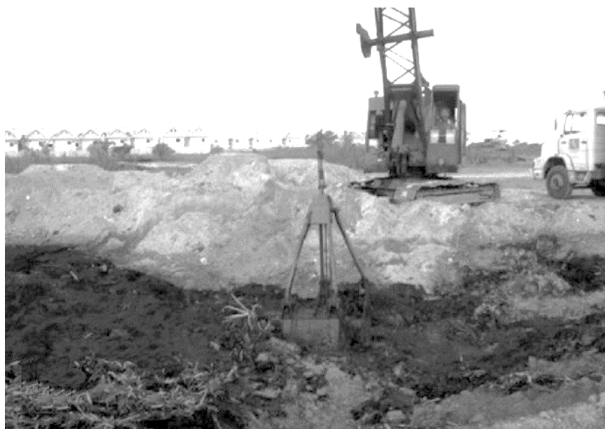
6.16. attēls. Grunts ekskavācija no sagatavotas darba platformas. [56]
