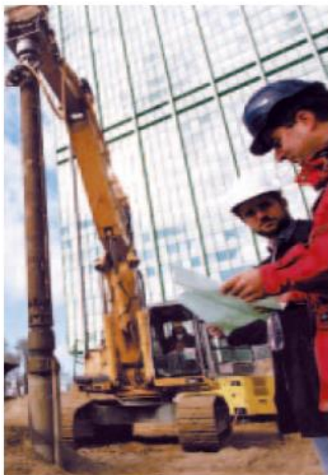
8.7. attēls. Grunts pāļu izbūve ar vibrācijas iekārtu apakšā un minerālmateriāla padošanu no augšas bez ūdens strūklas
