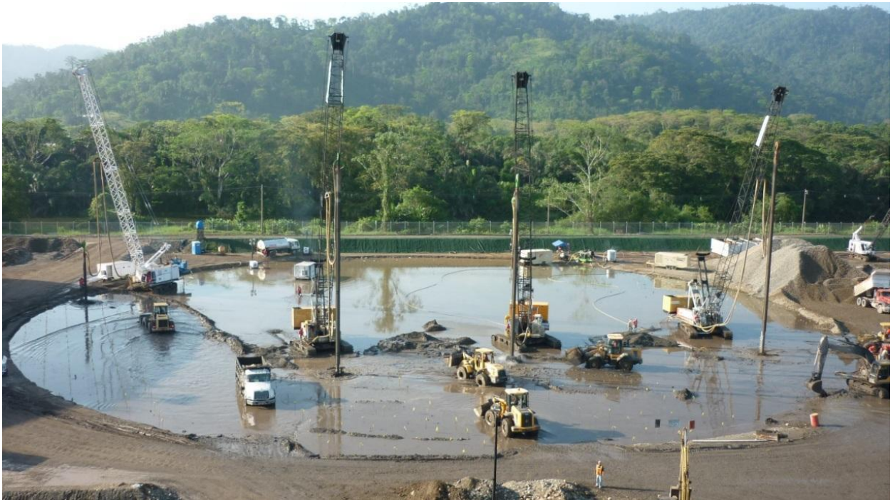
8.8. attēls. Grunts pāļu izbūve ar vibrācijas iekārtu apakšā un minerālmateriāla padošanu no augšas ar ūdens strūklu
