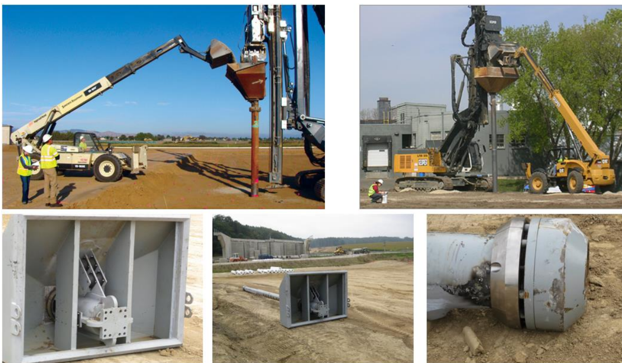
8.4. attēls. Grunts pāļu izbūve ar minerālmateriāla padošanu no apakšas un vibrācijas iekārtu augšā
